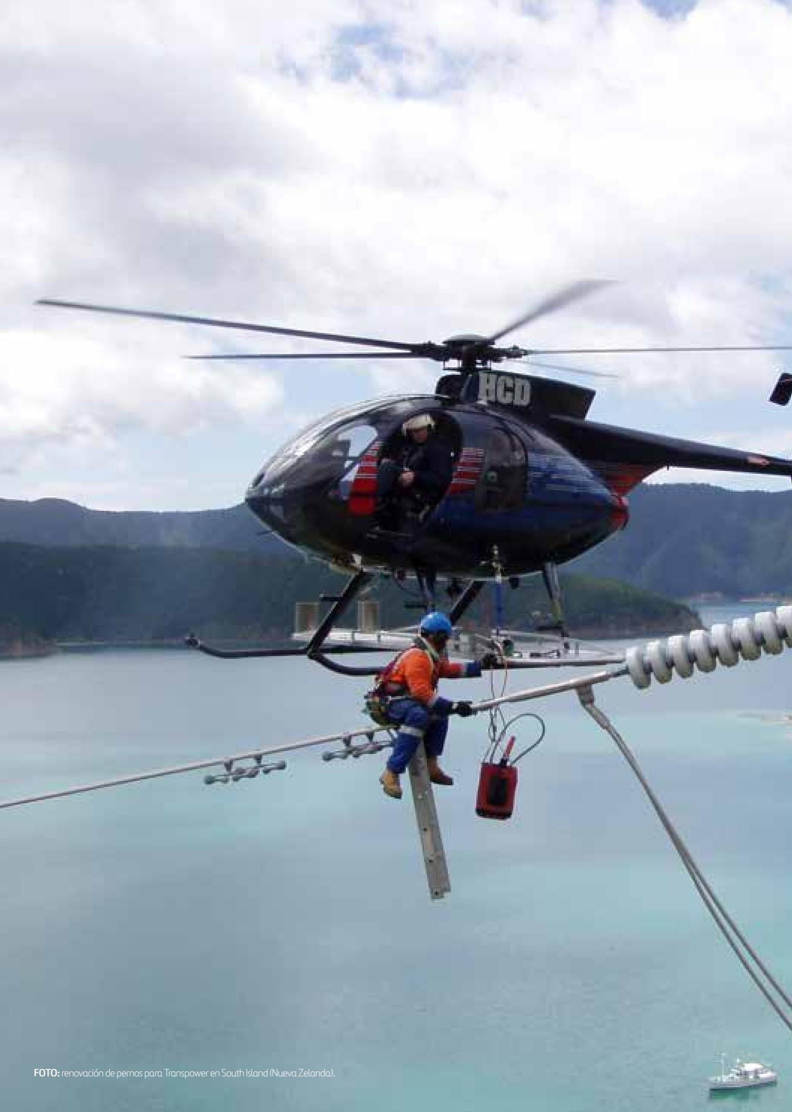
FOTO: renovación de pernos para Transpower en South Island (Nueva Zelanda).
